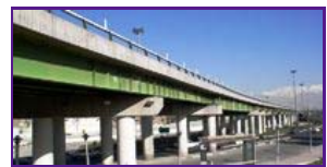
ساخت پل روگذر فلزی
